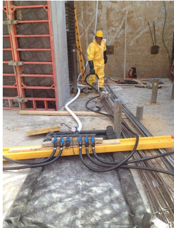
הזרקת מחמצן לפירוק כימי מלא של טריכלורואתילן באתר אלקו לשעבר תוך כדאי עבודות בנייה באתר.
